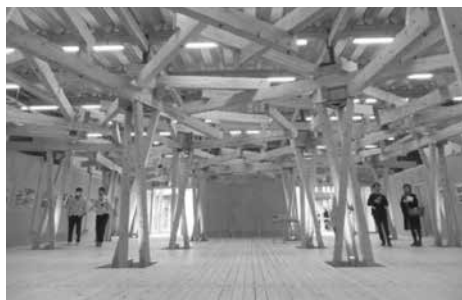
63の地方公共団体から提供された地域材により、「日本の伝統文化が感じられる木造」をコンセプトに建設
