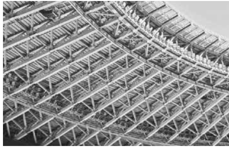
屋根はスギ・カラマツの集成材と鉄骨のハイブリッド構造
