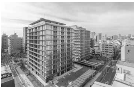
建物の一部を木造化した12階建て共同住宅「FLATS WOODS 木場」(東京都江東区) (写真提供：株式会社竹中工務店 設計部)
