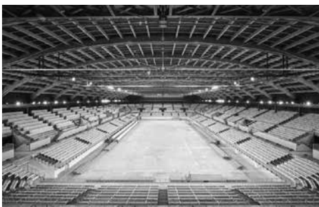
全長約90mのアーチ状の屋根の大梁にカラマツ約1,500m 3 が、観客席や外装の庇にスギが約800m 3 使われている
