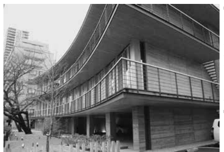
国内初の耐火木造オフィスビルで都市部での木造ビルのモデルプロジェクトを目指す。2、3階の架構に3層構造の耐火集材材「燃エンウッド」を使用。
