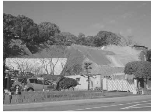
(熊本城復旧工事)
