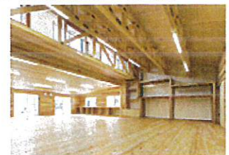
国産材ツーバイフォー製材により10mスパンの大空間を実現した幼稚園(千葉県富津市)
