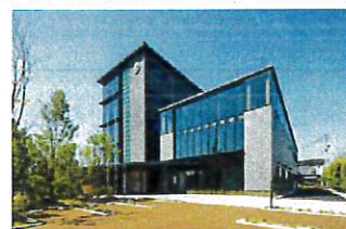
オフィスビル：松尾建設(株)(佐賀県)
