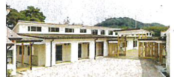
幼稚園舎(約1,300㎡)に約170㎡の国産材を使用
