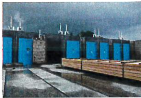
中核工場の乾燥施設
