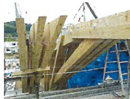
地域のスギ製材の組み合わせた大スパンの梁
