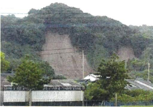
山腹崩壊の状況
